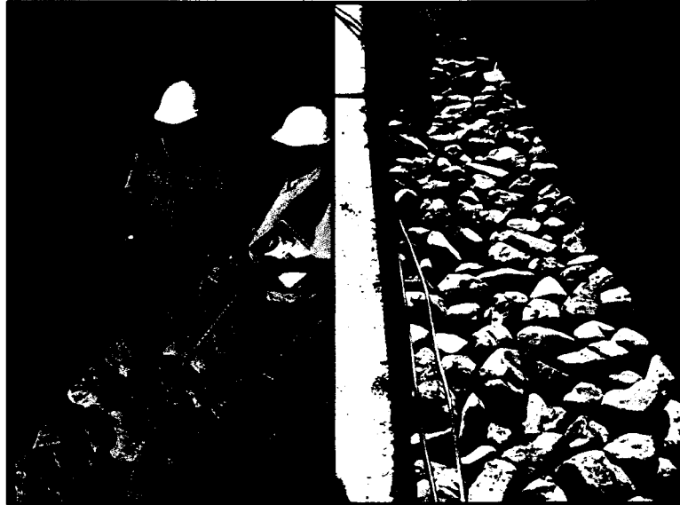
Colocado del Pedraplen en fondo de Canal.
