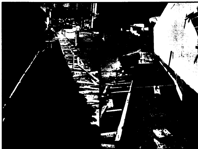
Vaciado de concreto f'c=175 \text{ kg/cm}^2 - Veredas SUPERVISOR DE OBRA
