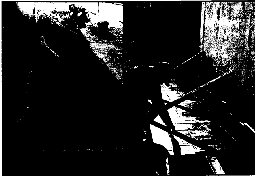
Acabado de Vereda f'c=175 \text{ kg/cm}^2
