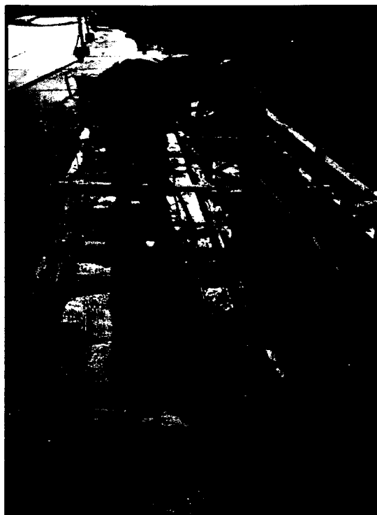
Vaciado de concreto f'c=210 kg/cm 2 . en muro de canal.
