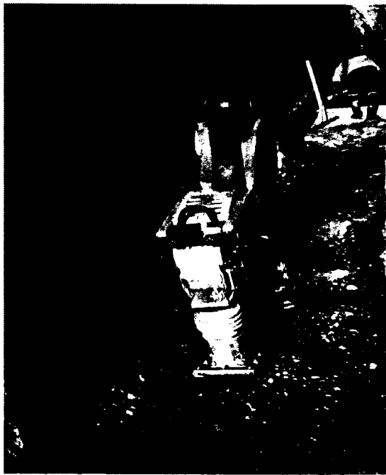
Se realiza la Compactación de material de préstamo, con equipo y EPPs adecuados.
